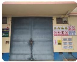
▲ 倉庫外張貼警示標示
